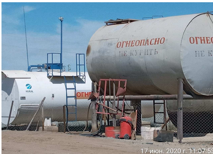
Рис. 12. Площадка хранения ГСМ, Производственная база “Ногайты” Лот 3, 17 июня 2020 г.
