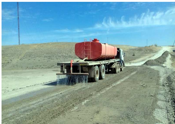
Рис. 14. Пылеподавление на участке Лот 2, 18 июня 2020 года
