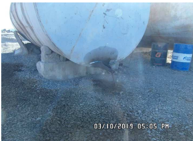
Разливы на площадке хранения ГСМ, Производственная база п. Караулкелды, Аудит октябрь 2019 г.
