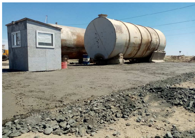
Бетонирование площадки под емкостью хранения ГСМ, Производственная база п. Караулкелды, Аудит май 2020 г.
