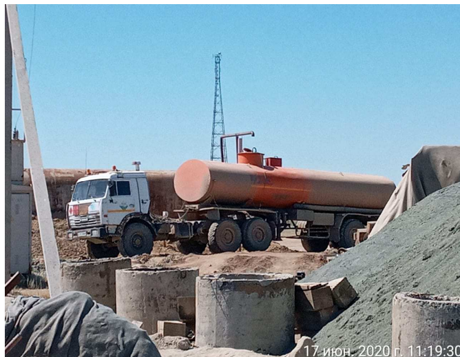
Аудит от 17.06.2020 г. ж/б кольца для обустройства септика для сбора жидких отходов
