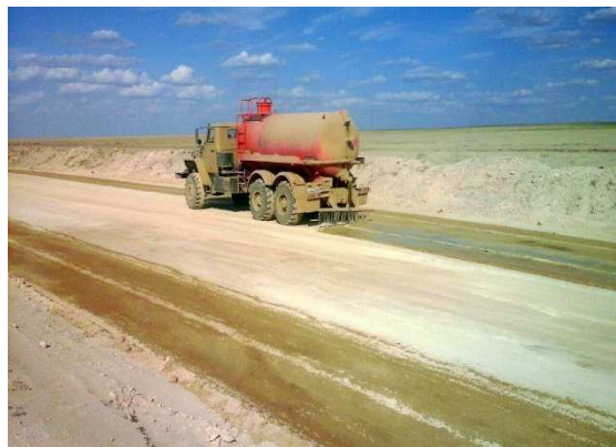
Рис. 15. Пылеподавление на участке Лот 3, 21 мая 2020 года
